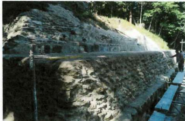
Edificio 389- Resultado del trabajo realizado en el edificio.
