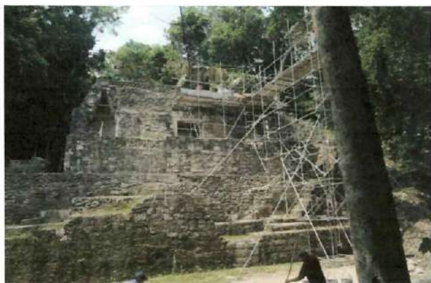
Figura No. 020. Edificio 375- Sistema de andamiaje construido para facilitar los trabajos
