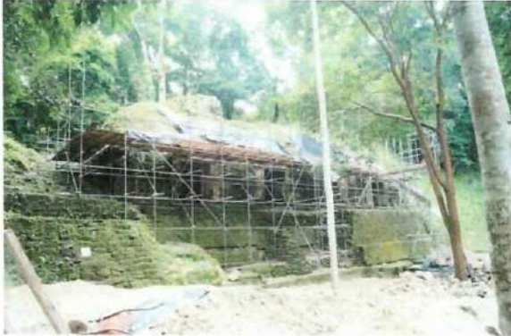
Figura No. 014. Edificio 389, proceso del trabajo en donde se muestra el sistema de andamiaje construido.
