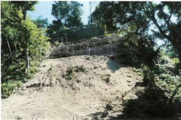
Figura No. 006. Edificio B-24, fachada norte, proceso del trabajo en la recuperación de volumen en los cuerpos de la pirámide.
