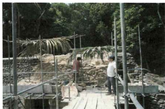
Figura No. 021. Edificio 375- Proceso del trabajo de recuperación de volumen removido en la parte superior del edificio.
