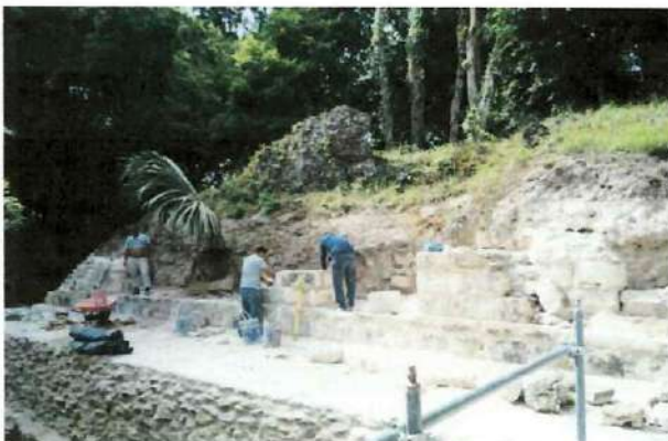
Figura No. 018. Edificio 389, proceso del trabajo, personal definiendo arranque de muros del segundo piso del palacio.
