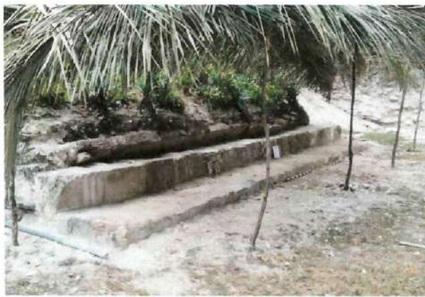
Figura No. 13. Edificio B-14, proceso de la restauración en los escalones ubicado en la fachada sur.
