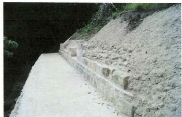
Figura No. 019. Edificio 389, Apariencia del edificio concluido los trabajos de conservación realizados en él.
