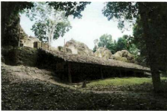
Figura 023. Edificio 6J2, vista desde el oeste, estado del edificio antes de desmontar la cubierta sobre el edificio 6J2-Sub.
