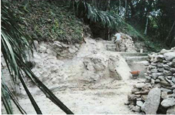
Figura No. 009. Edificio B-17, proceso de la restauración de arquitectura expuesta.
