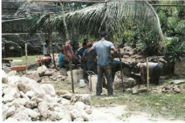
Figura No. 012. Edificio B-14, Personal que realiza los trabajos en la escalinata.
