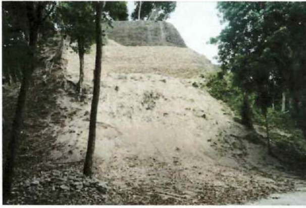
Edificio B-24, en las fotografías de la izquierda el resultado de la intervención hecha sobre el edificio en la fachada norte.
