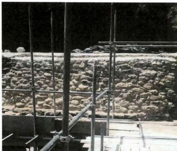
Edificio 375- Proceso del trabajo de recuperación de volumen removido en la parte superior del edificio.
