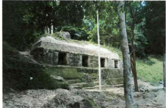
Figura No. 015. Edificio 389, Apariencia del edificio concluido los trabajos de conservación.
