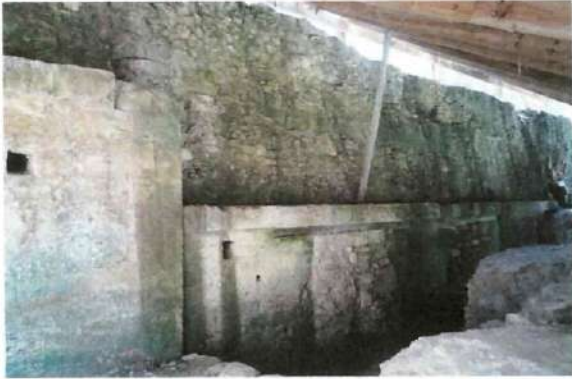
Edificio 6J2 Sub, antes de iniciar con la ejecución de las medidas emergentes.
