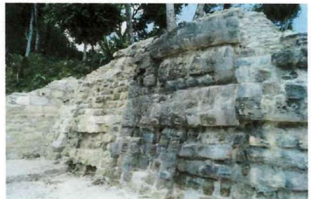
Edificio B-24, fachada norte. Resultado de los trabajos de estabilización de sillares.
