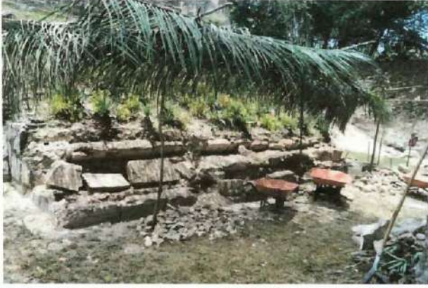
Figura No. 011. Edificio B-14, estado en que se encontraron los sillares que dan forma a la escalinata.
