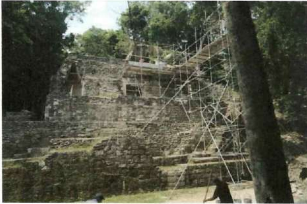
Edificio 375- Sistema de andamiaje construido para facilitar los trabajos sobre el edificio.
