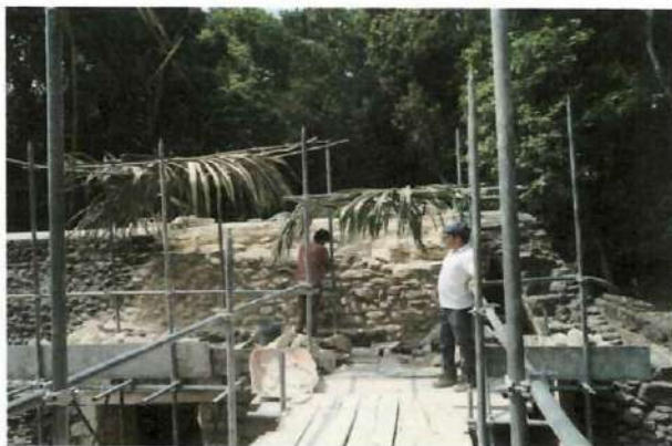
Edificio 375- Proceso del trabajo de recuperación de volumen removido en la parte superior del edificio.
