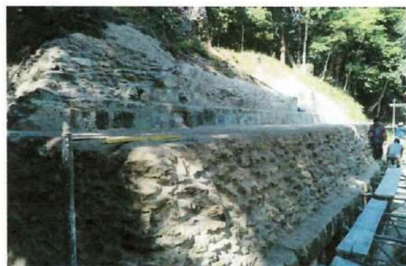
Figura No. 017. Edificio 389, Apariencia del edificio concluido los trabajos de conservación realizados en él.
