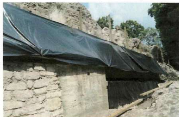
Figura 026. Edificio 6J2, Cubierta temporal en el lado oeste.
